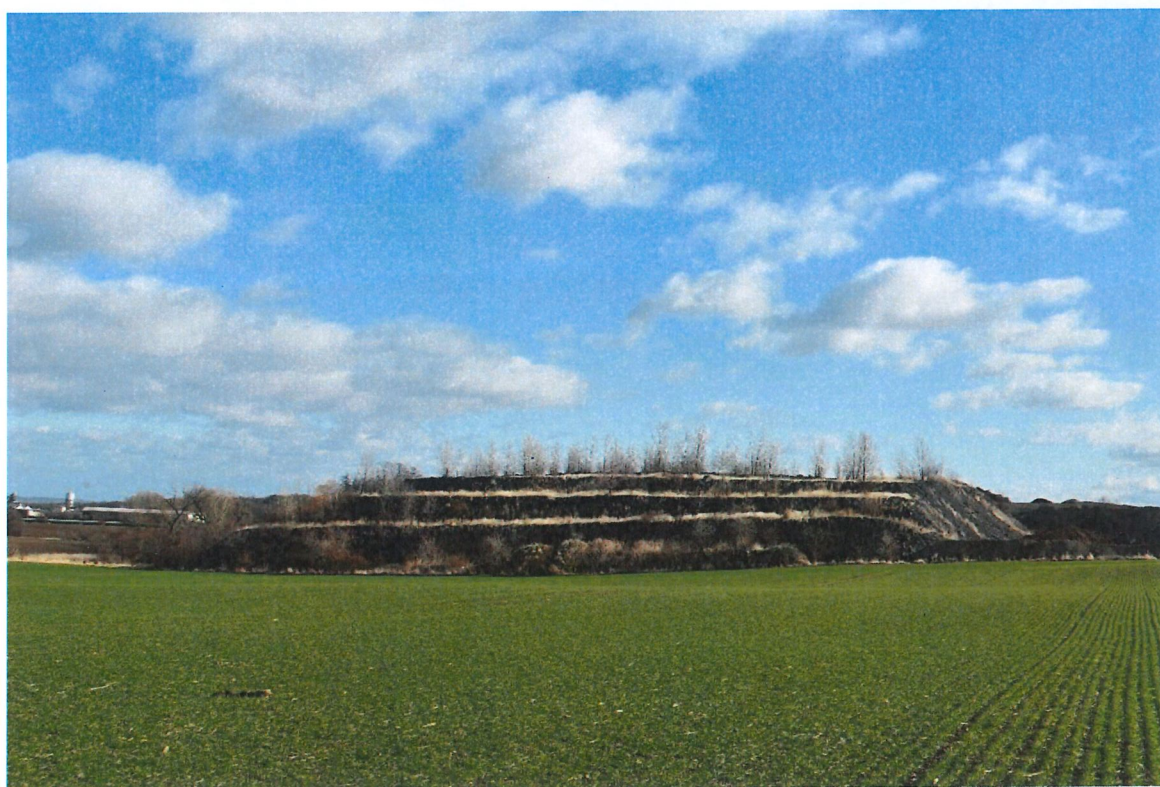
Obrázek 10 - pohled od západu na severní polovinu deponie
