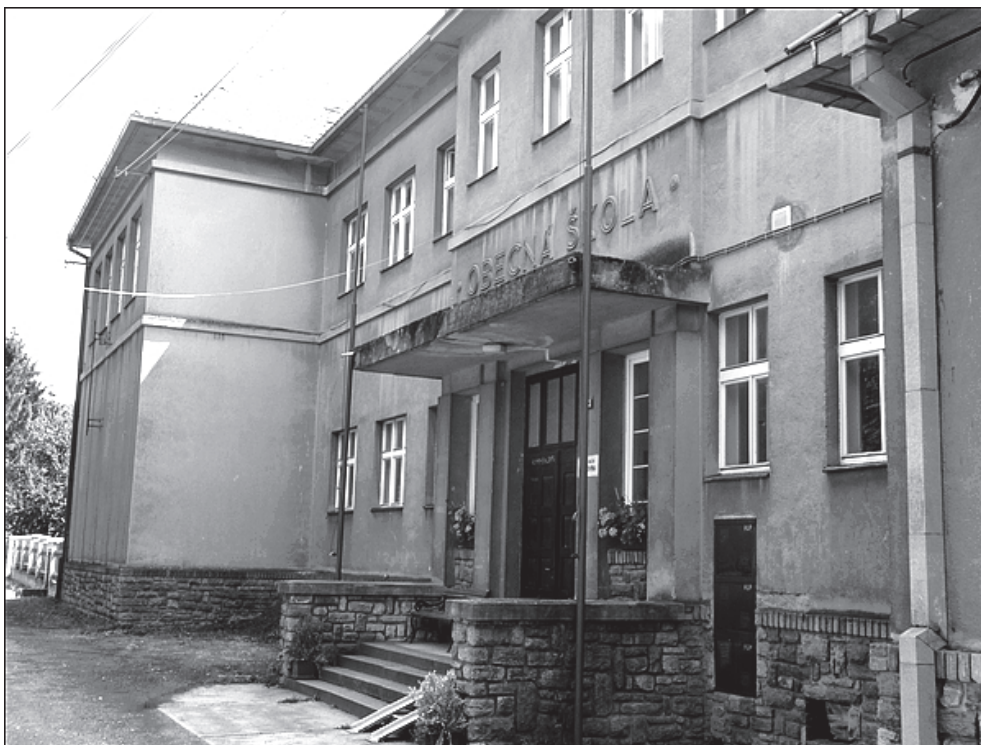
F5 – bývalá škola
