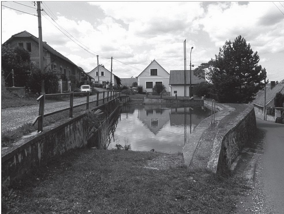
F10 – požární nádrž
