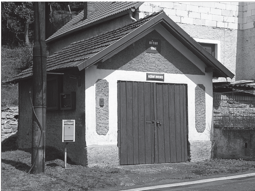
F18 – požární zbrojnice
