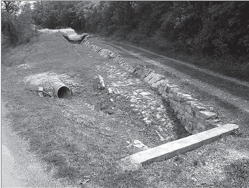
F11 – příkop povrchové kanalizace
