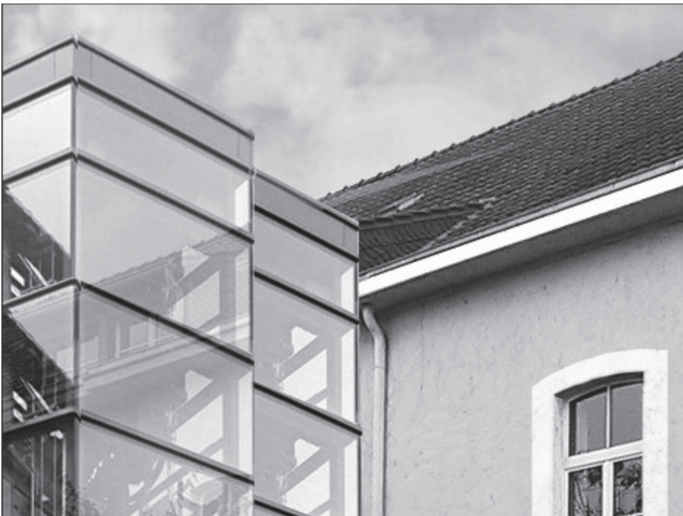
Bezbariérové úpravy - výtah
