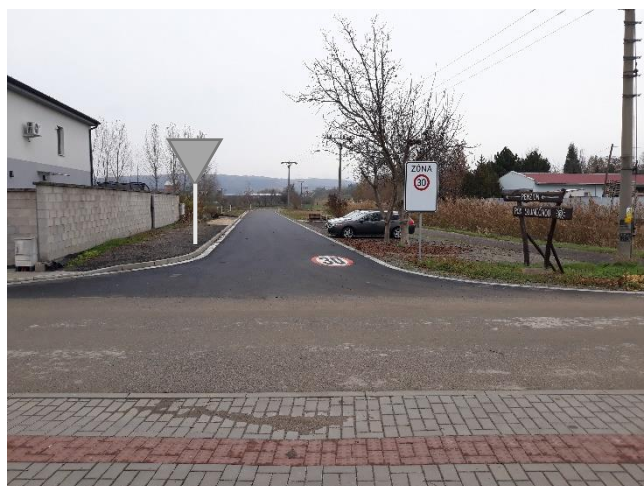
Foto č. 4 – pohled na křižovatku a nově vybudovanou místní komunikaci
